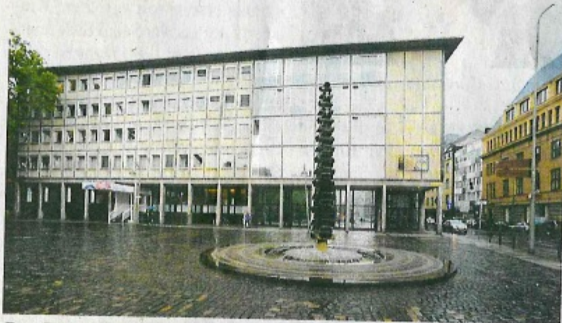
Das IHK-Gebäude an der Straße Unter Sachsenhausen ist mit Asbest belastet, was die Modernisierung verteuert. Archivfoto: Worring
